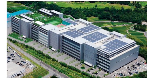
Solar power system (Kuwabata Plant)
